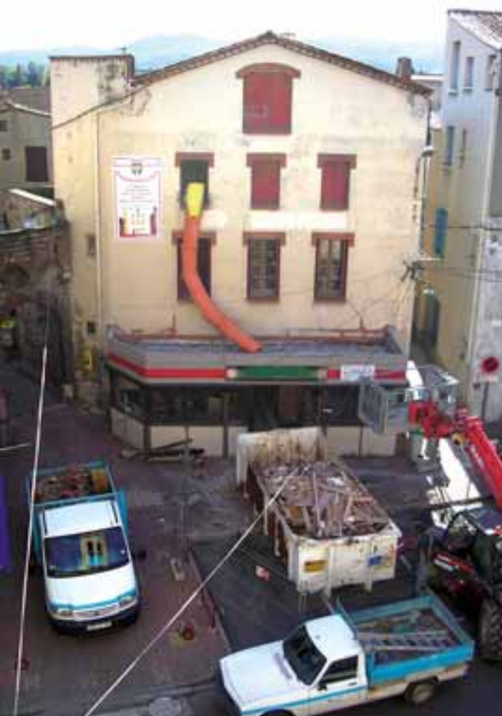
Les travaux de la restauration du bâtiment "LE CENTRAL" ont démarré en octobre 2005.
