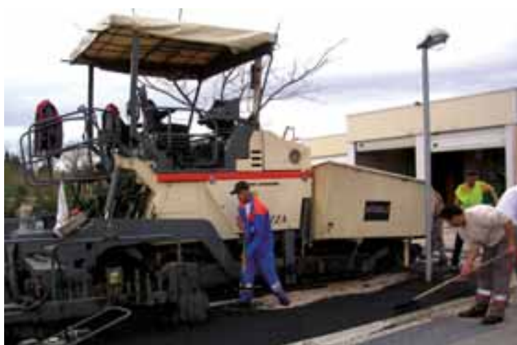
Aménagement des abords du centre technique municipal n°1.
