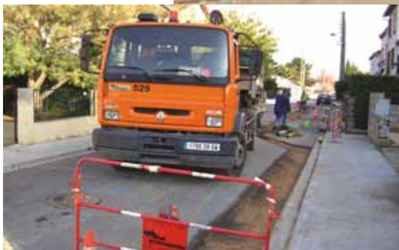
Arrivée du gaz naturel à la rue Concorde.
