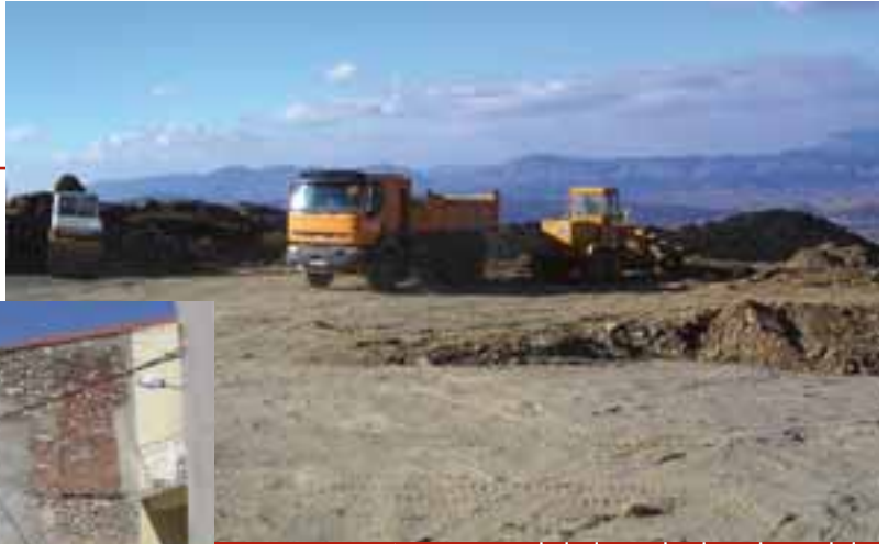
Aménagement de la route départementale de FORÇA-REAL - création de la plate-forme d'arrivée.
